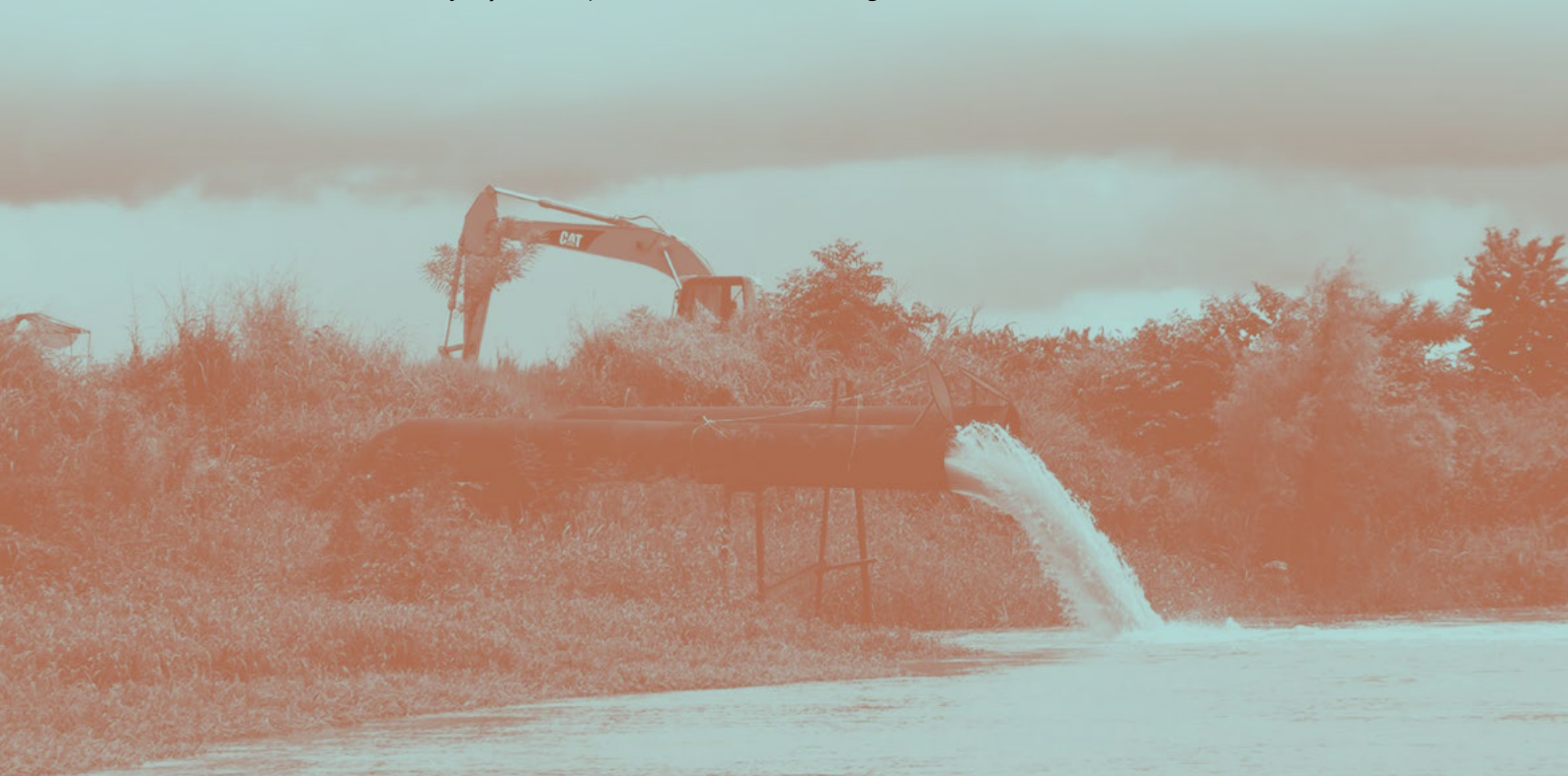
Màquines treballant per expulsar l'excés d'aigua de la plantació en el riu Pacayá.
